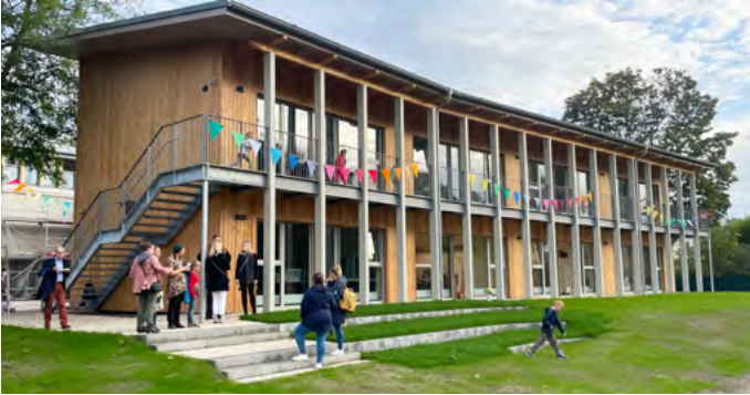
Das neue Schulgebäude wurde in nachhaltiger Holzbauweise errichtet.
